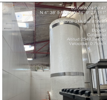
Foto No.5. Tanque sedimentador
